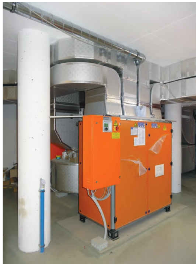
La centrale termica comprende tre caldaie a condensazione e un cogeneratore a gas metano, con predisposizione per l'installazione di altri due cogeneratori, oltre a tre capienti serbatoi per l'accumulo termico (Studio Delazer).
