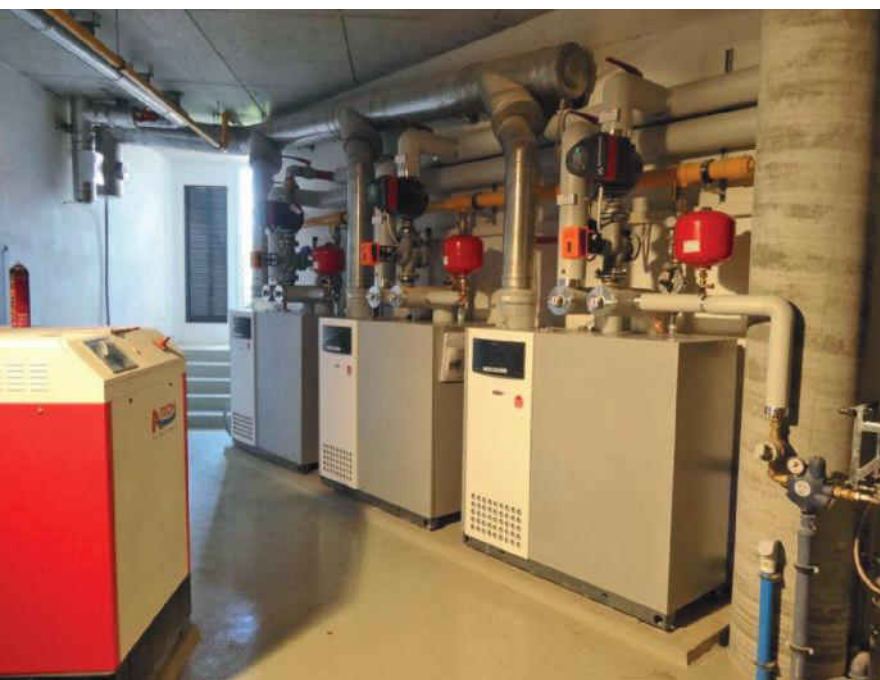
La centrale termica comprende tre caldaie a condensazione e un cogeneratore a gas metano, con predisposizione per l'installazione di altri due cogeneratori, oltre a tre capienti serbatoi per l'accumulo termico (Studio Delazer).
